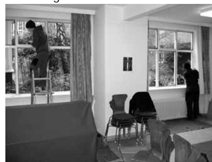
Die Handwerker bei der Arbeit
